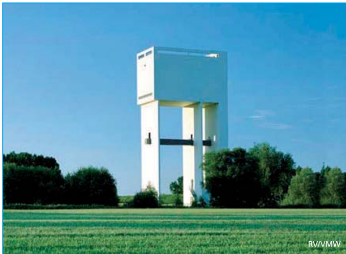
In het systeem zijn per locatie de machines gelinkt, de specifieke werking is uitgelegd, de manier van onderhoud, de kwaliteitsprocedures, enz. (de VMW-watertoren in Tienen).
